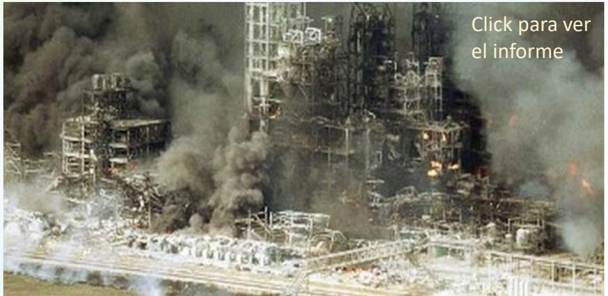
Parece haberse usado etileno para “barrer” un residuo de polietileno en un drenaje de proceso del reactor. Para ello se abrió una válvula “sellada” que era parte del Sistema de Aislamiento de Fuentes de Energía
